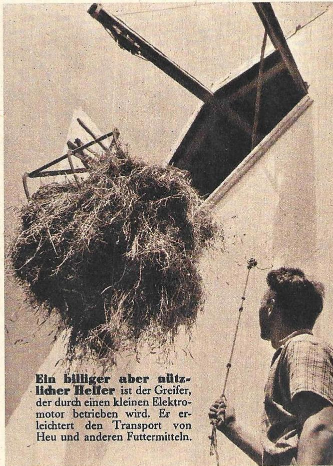
Ein billiger aber nützlicher Helfer ist der Greifer, der durch einen kleinen Elektromotor betrieben wird. Er erleichtert den Transport von Heu und anderen Futtermitteln.
