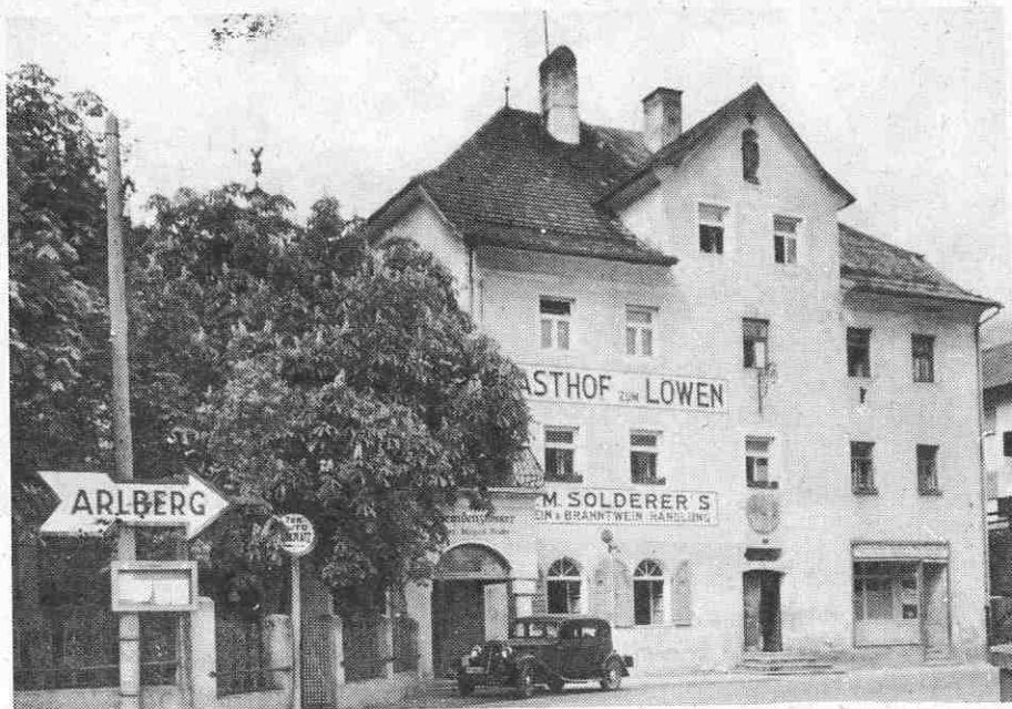
Gasthof und Pension zum Löwen, Landeck Der rechte Teil des Hauses wurde im Mai 1990 abgerissen.
