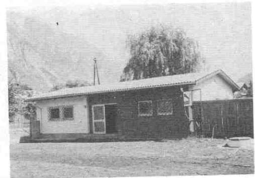
Das Kabinengebäude am Landecker Sportplatz wird aufgestockt.
