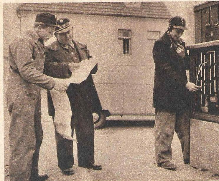
**Vom zweiten Jahr an** haben die Lehrlinge Außendienst zu arbeiten sich langsam zur Selbständigkeit hinauf. Hier wird unter Anleitung eines Werkmeisters eine selbstgelegte Telephonleitung überprüft.
