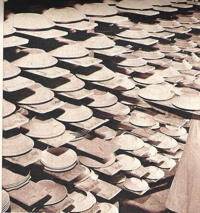
Teller werden handgedreht und nicht, wie das übrige Porzellan, in Formen gegossen. Hier werden sie zum Trocknen in Formen aufgelegt. Die vorgesehnen Tellerränder sind bereits deutlich zu sehen.
