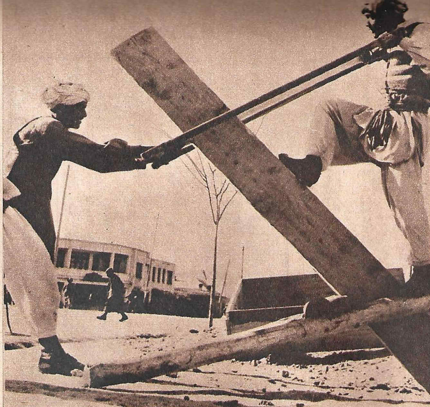
Große Fortschritte macht man auch in Nepal in den Methoden der Verarbeitung, berichtet ein dorthin entsandter Experte der Internationalen Arbeitsorganisation der Vereinten Nationen (ILO), der diesen Schnappschuß einspart. Aber die hier gezeigte Art, ein Brett zu zersägen, wird noch oft genug angewandt.
