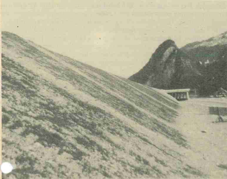
„Sehr genaue“ Böschung östlich von Zams.
