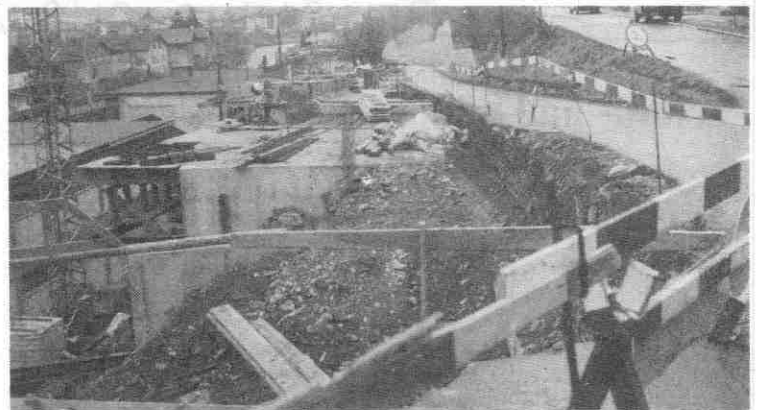
Das „Neue Straß“ im jetzigen Ausbaustadium
