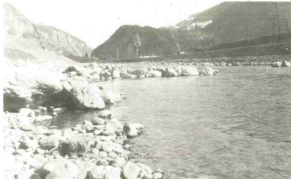
Das verlegte Innbett erhielt nachträglich Steinsporne, die dem Kanal-Effekt der glatten Böschungen entgegenwirken.
