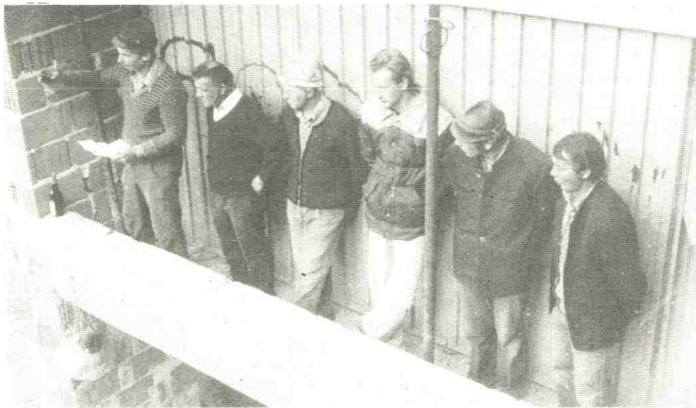
Polier Josef Zangerle sagte nach altem Brauch den Spruch zur „Aufrichti“
