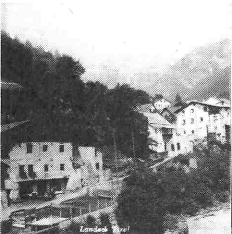
Die »Garb« in Landeck vor dem Abbruch
