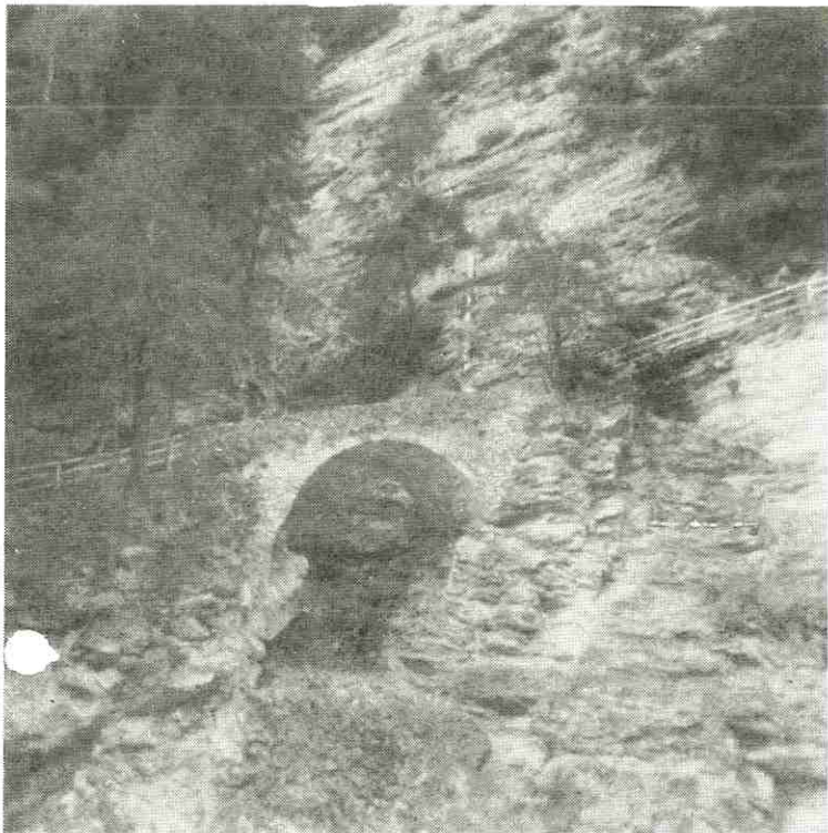
Die Tösener Römerbrücke ist renoviert und wieder benützbar.
