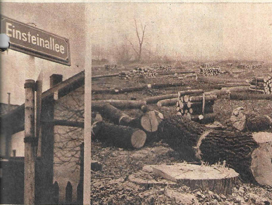
DER RICHTIGE PLATZ für das neue deutsche Atomkraftwerk ist die Einsteinallee in Karlsruhe (links), wo bereits der Bauplatz vorbereitet wird (rechtes Bild). Das Holz der auf dem Bauplatz gefällten Bäume soll beim Bau verwendet werden. Die Anlage soll vor allem der Nutzung der Atomenergie in der Technik, Medizin, Landwirtschaft etc. dienen. Die Anwendung der Atomenergie für friedliche Zwecke wird durch das Euratomprojekt, das die gemeinsame Durchführung aller Atomprojekte der europäischen Staaten zum Ziele hat, besonders gefördert.
