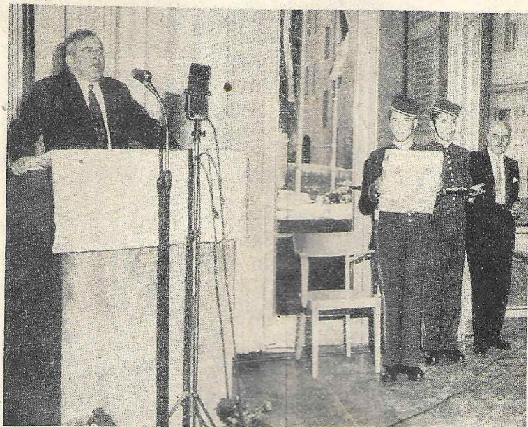
In Innsbruck wurde das an Stelle einer Bombenruine erbaute Hotel Tyrol eröffnet. Der Feierlichkeit wohnten die Bundesminister Dr. Kamitz und Dr. Illig, Bürgermeister Dr. Greitner sowie Vertreter der MEC, die den Bau finanzierte, bei.
