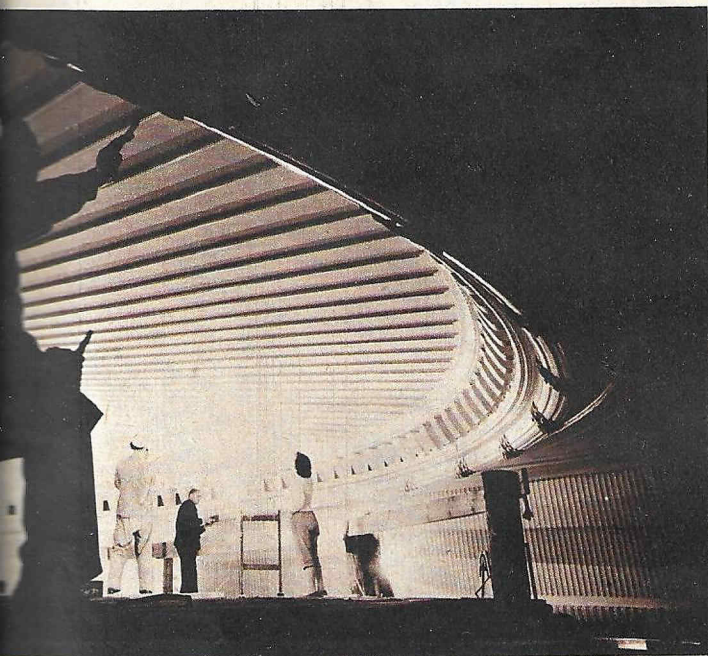
Bei der Arbeit an der Strahlendecke des Zuschauerraumes. Die Pfeiler der dritten und vierten Galerie sind fortgefallen.
