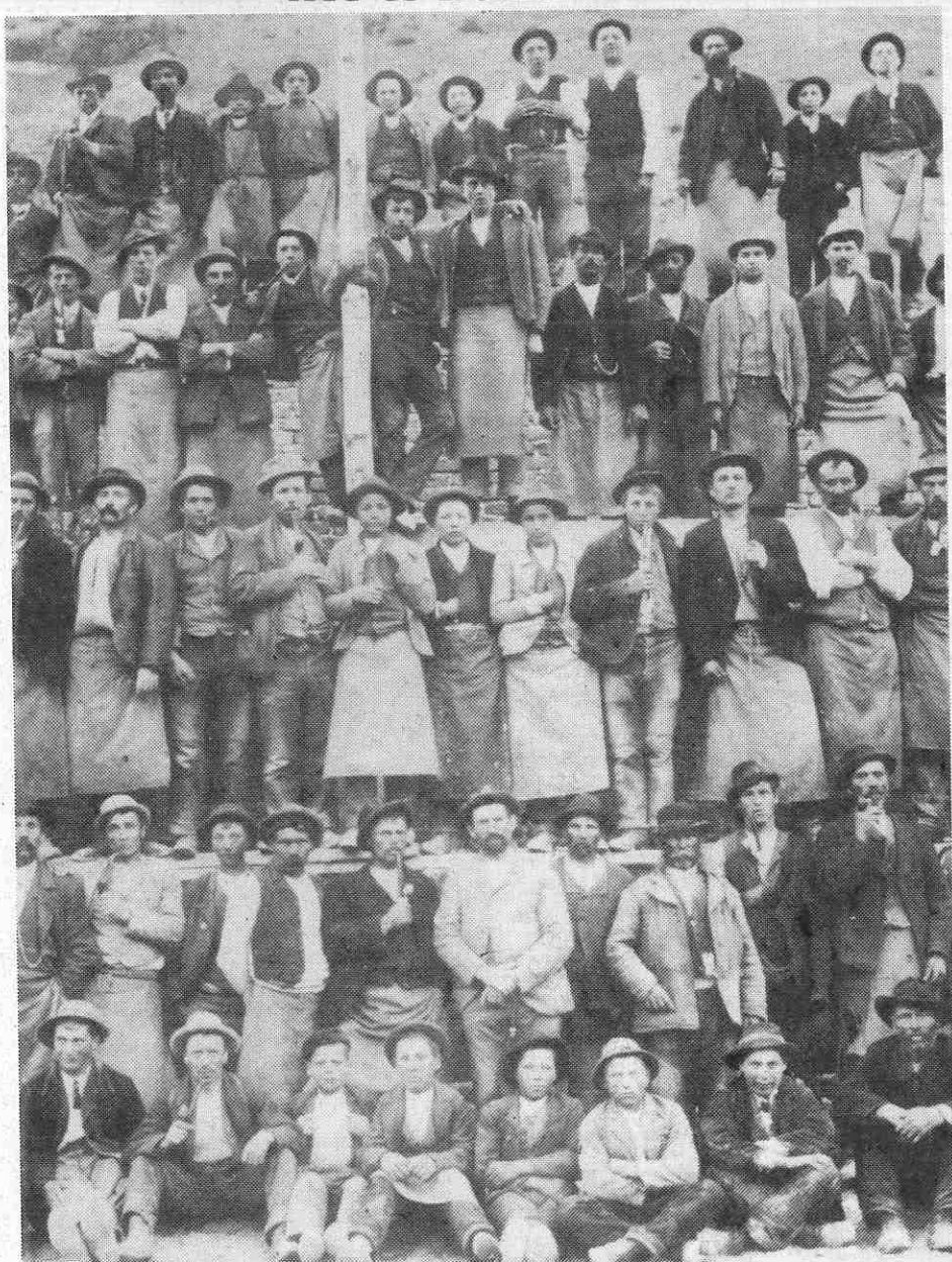
Ein Trupp Oberländer Wanderarbeiter beim Bau der Eidgenössischen Schützenhalle in Zürich 1907; Foto: J. Hage, Zürich; Beschriftung auf der Bildrückseite: Johann Walser, Hochgallmigg. Das Bild ist dem Buch »Photographie im Tiroler Oberland 1850-1950« von Willi Pechtl entnommen.
