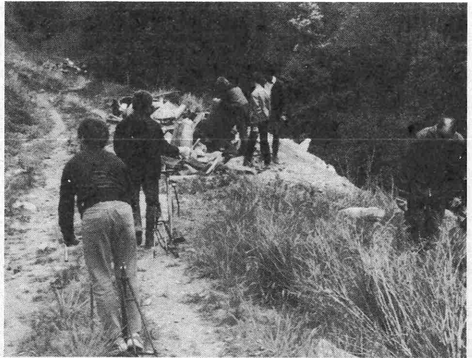
L.E. Aufräumungsarbeiten in Pfunds
