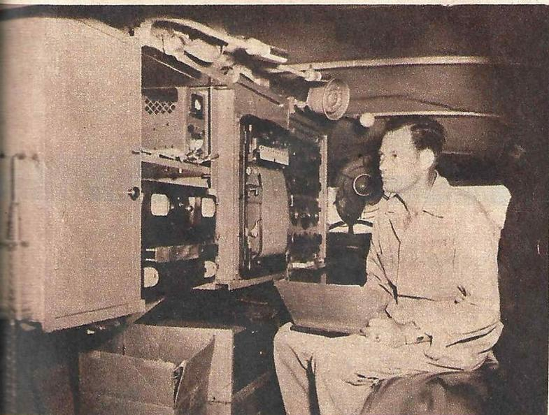
Tief in der Erde lösen die vom Reaktor ausgesandten Neutronen atomare Reaktionen aus, die von Meßgeräten (Bild) aufgezeichnet werden und Rückschlüsse auf Lage und Umfang der Ölvorkommen zulassen.
