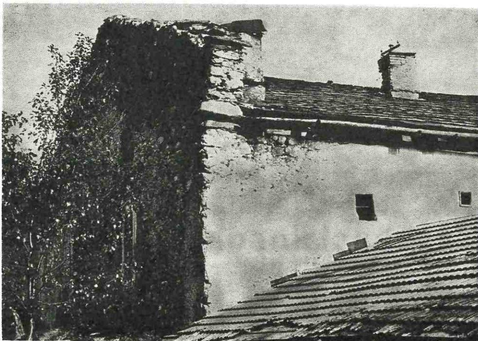
Die West- und Nordansicht des unteren Hauses in der Point. Die winzigen Kammerfenster über dem Dach des angebauten Schuppens sind deutlich sichtbar. Die Putzumrahmung der zugemauerten Tür an der Nordmauer ist gerade noch zu erkennen.
