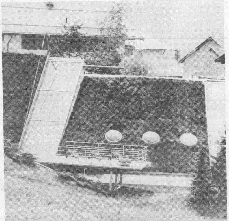
Die bereits fertige Seite des Hallenbades der Maximilian OHG in Serfaus.
