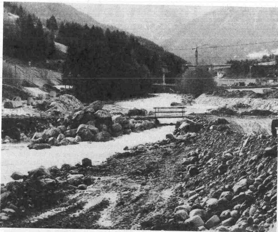
Die Verlegung der Sanna in Landeck.
