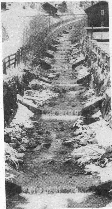
Wildbachverbauung in Flirsch.
