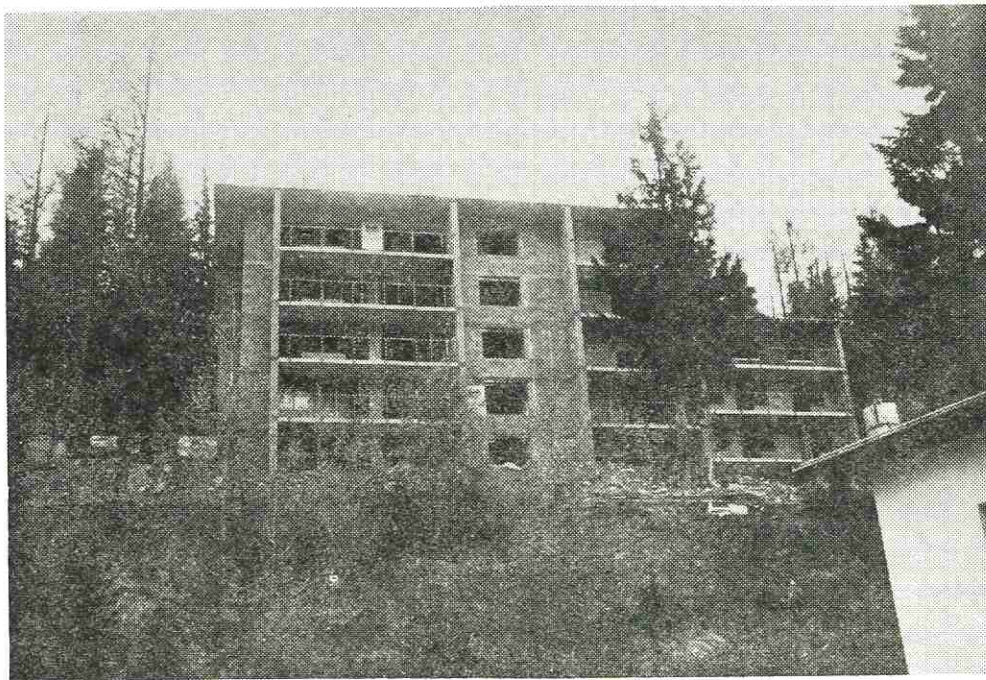
Der Rohbau für 16 Eigentumswohnungen
