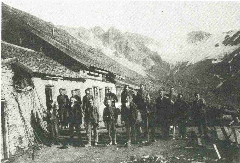
Das frühere Bleibergwerk bei Tösens/Steinbrücke;
