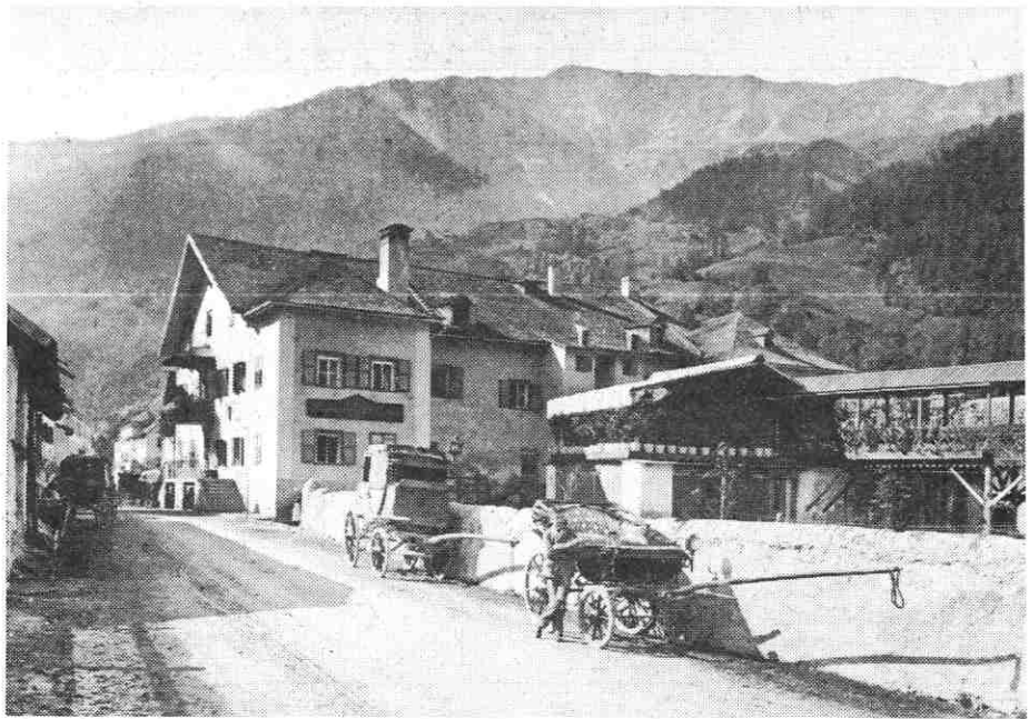
Aufnahme vom »Gasthof Post« um 1890, noch vor dem Umbau, der 1895 erfolgte.
