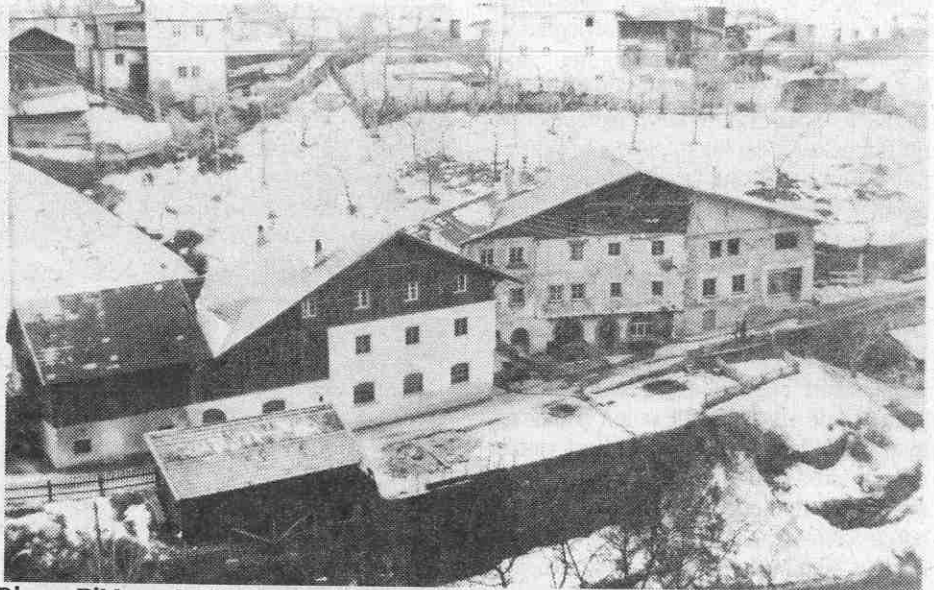
Dieses Bild wurde 1951 aufgenommen (Mathis). Der Umbau des nördlichen Gebäudeteils steht im Rohbau. An Stelle des Stalles wurde 1946 das Gebäude für die Gerberei errichtet. Die Innverbauung ist noch nicht durchgeführt.
