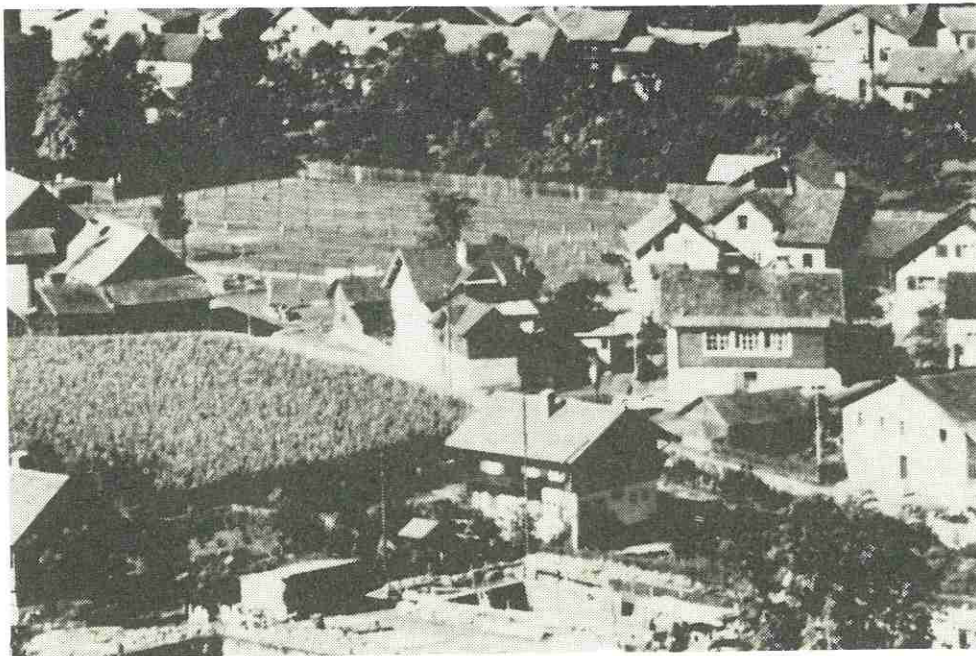
Der alte Viehmarktplatz auf der Öd. Im Vordergrund sieht man die Baugruben der Unteroffiziershäuser, mit deren Errichtung noch vor Kriegsbeginn begonnen wurde. Das Bild wurde von Herrn Franz Schrott zur Verfügung gestellt.
