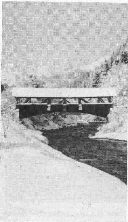
1978 wurde auch die »Seßlebener Brücke« durch eine Betonbrücke ersetzt.
