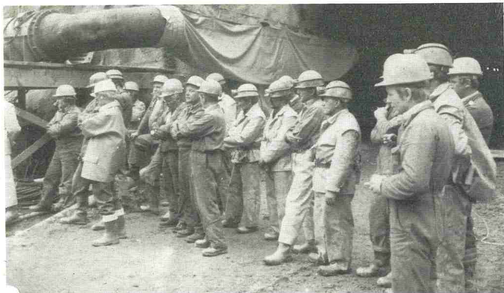
Die Porr-Mineure mit Bauführer Prax und Ing. Wurnig
