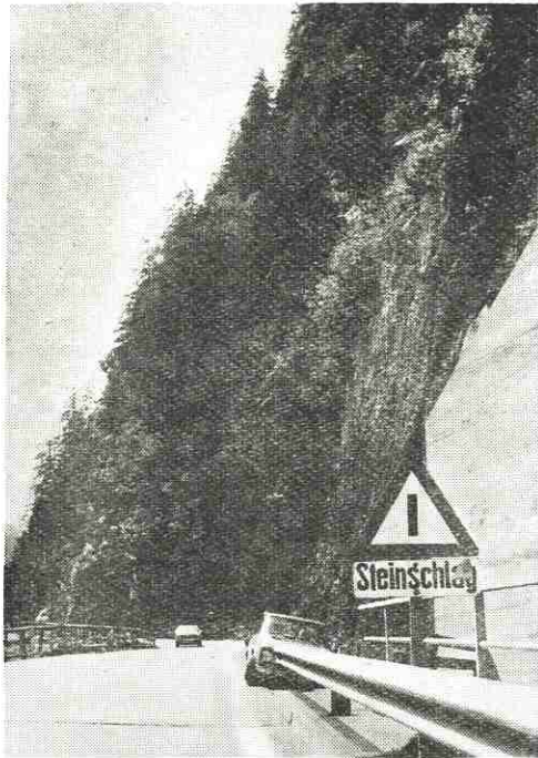
Steinschlaggefahr am Gföll.
