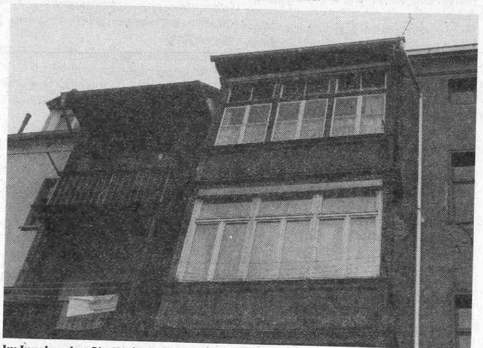
Im Innsbrucker Stadtteil Hötting: Angeeignete Fassade, die nicht nur den Wohnraum vergrößert
