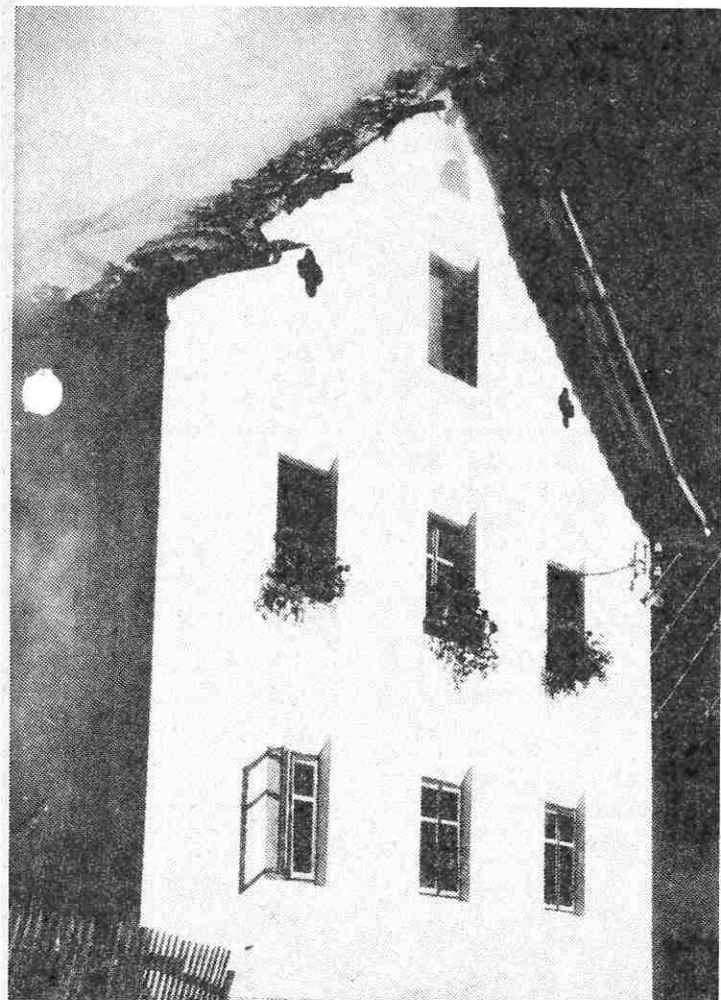
Vergangene Woche brannte das Wirtschaftsgebäude des Josef Rudiger in Wiesberg, Gemeinde Tobadill, vollständig ab. Das Wohnhaus wurde schwer beschädigt. Der Gesamtschaden beläuft sich auf rund 1,5 Millionen Schilling.
