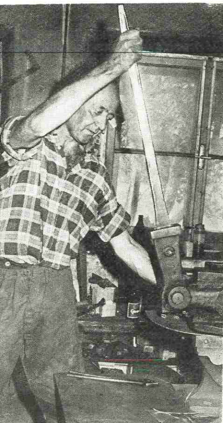
Die Schellenformen werden aus dem 2 mm-blech ausgeschnitten.
