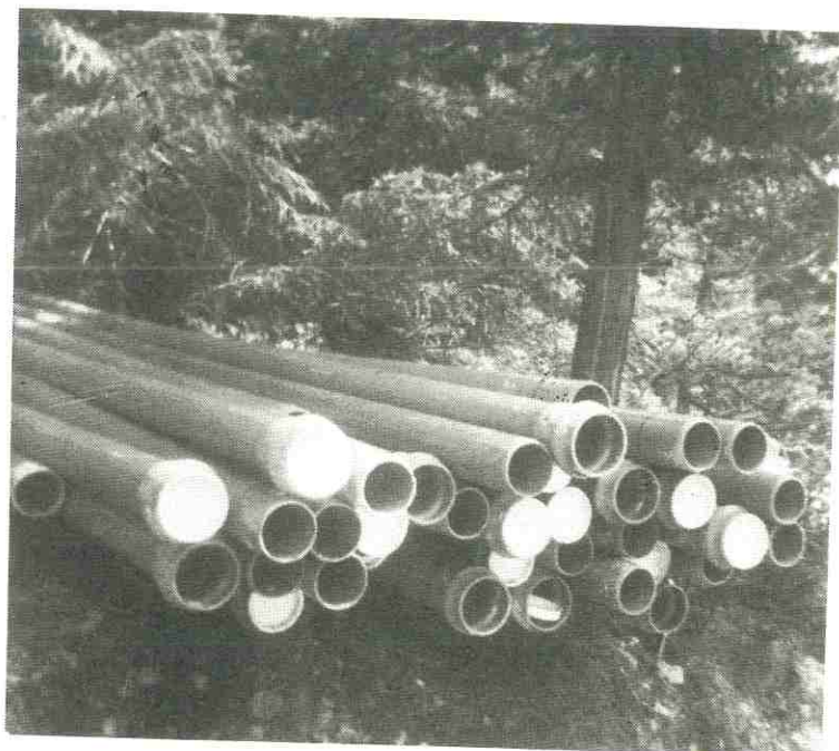
In den Gräben werden die Rohre verlegt
