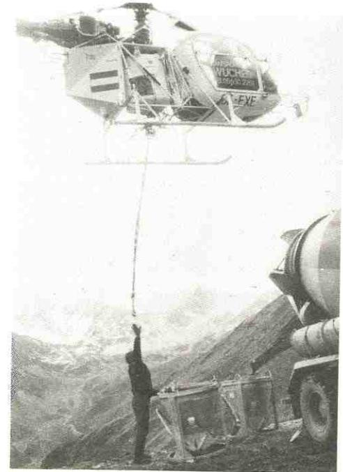
Mit einem Hubschrauber der Firma Wucher aus Ludesch wurde der Beton für die Stützenfundamente angeliefert.
