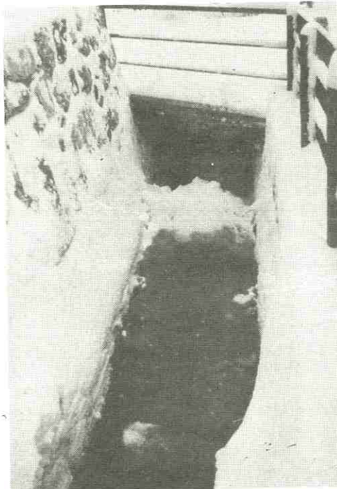
So wird das Wasser im Kanal durch Schneeablagerungen immer wieder gestaut.
