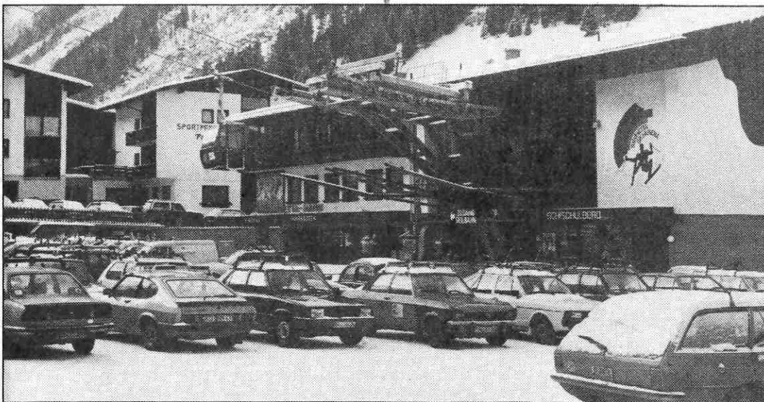
Die »neue« Silvretta-Bahn: vor 5 Jahren in Betrieb genommen und die Grundlage für einen weiteren Aufschwung im Ort.
