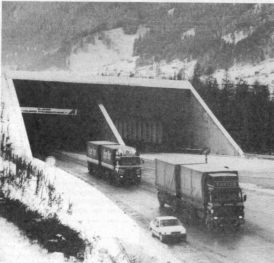
Vor 10 Jahren, am 1. Dezember 1978, wurde der 13.972 m lange Arlberg Straßentunnel dem Verkehr übergeben.
