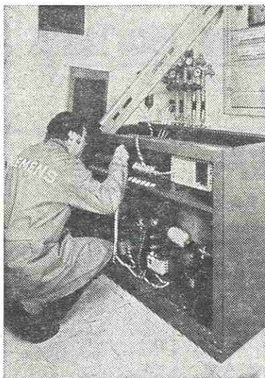
Justagearbeiten an der Siemens-Wärmepumpe in einem Einfamilienhaus in Salzburg. Siemens-Pressebild
