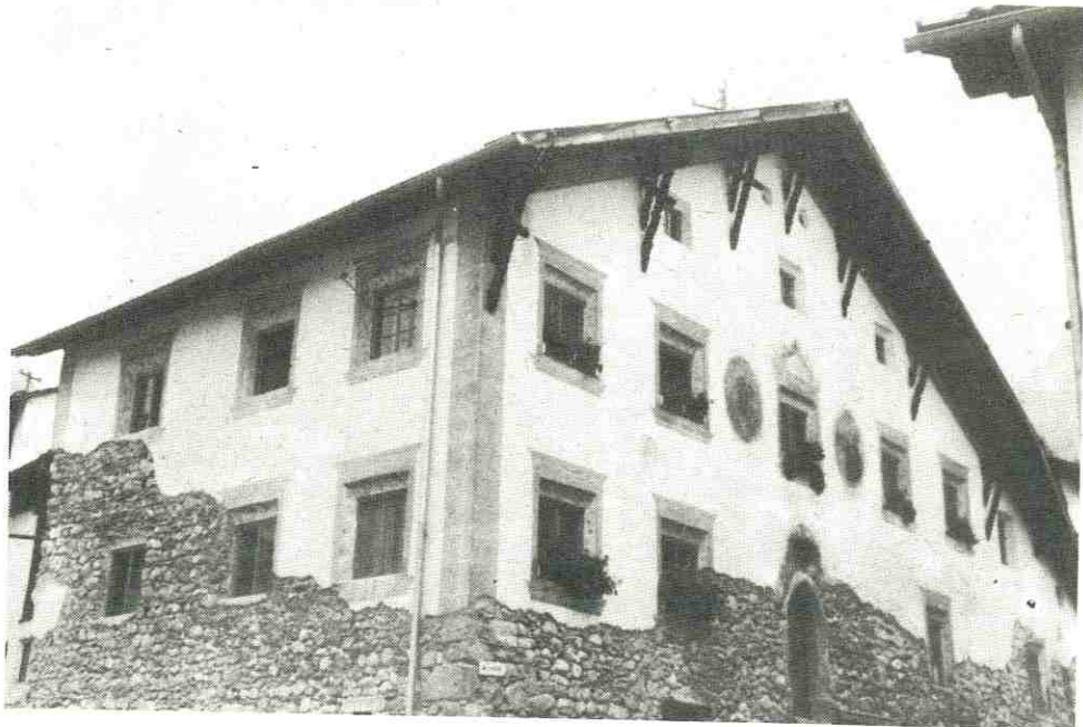
Das Leitnerhaus wird im Rahmen der Fassadenaktion gegenwärtig renoviert.
