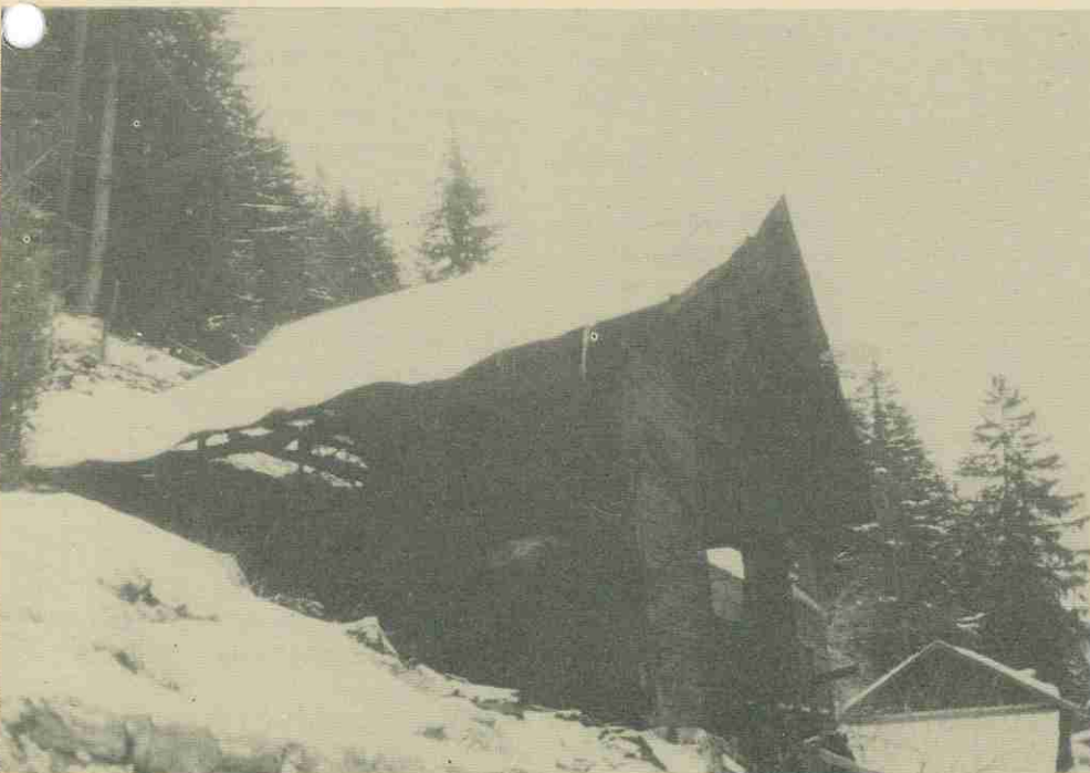
Die Brandruine der alten Mühle in Kaunerberg
