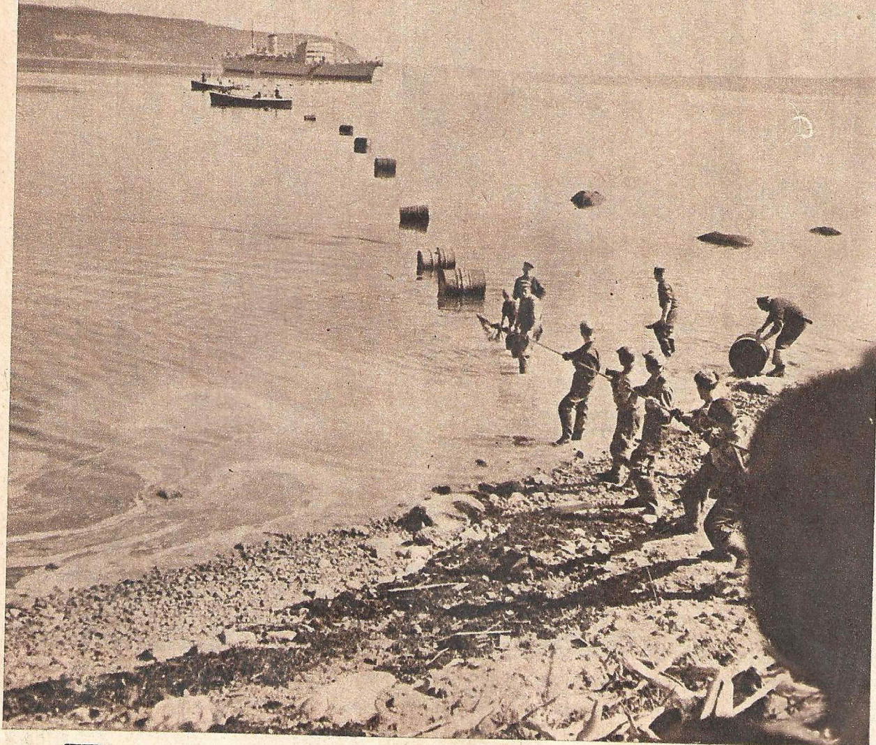
Die Krönung dieser langer Arbeit: Das zweite Transatlantik-Telephonkabel, das von Schottland auf die Insel gelegt wurde, wird bei Cape Cod (New England) auf dem Grund ankernd.
