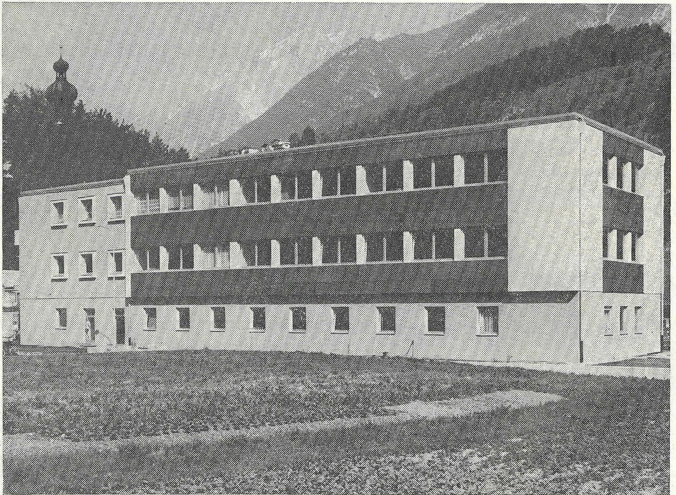
Neues Fernmeldegebäude in Landeck
