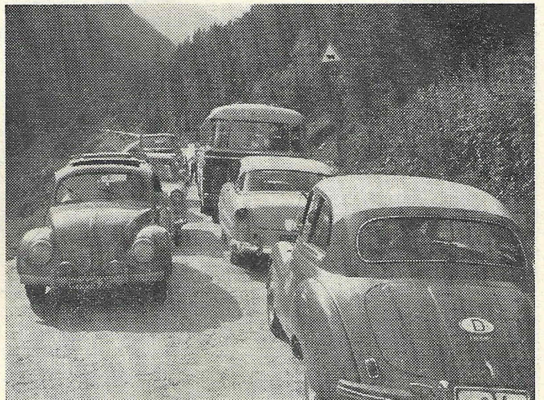
So sieht es bei der westlichen Einfahrt zur Straßenbaustelle aus. An der, auf Einfahrt in die Baustelle wartende Fahrzeugkolonne, ist es für einen Omnibus fast nicht möglich, vorbei zu kommen.
