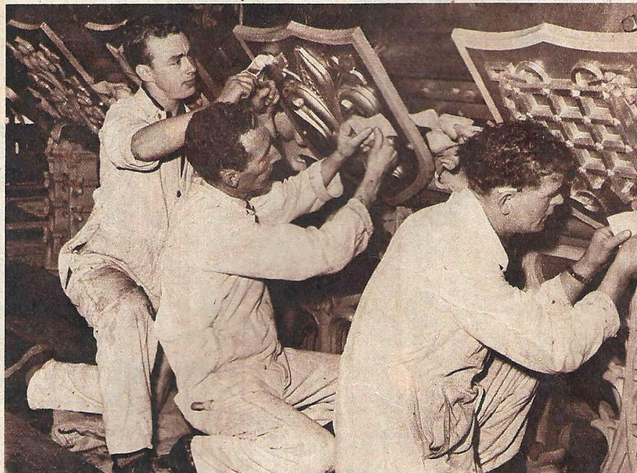
Wirklich „auf Glanz geputzt“ wird auch die Außenseite des Turmes. Für die glasung der Zifferblätter (links) wurden fast 1000 Glasscheiben benötigt. Oben: Die goldung der Schmiedeeisenteile gehörte ebenso wie die Ausbesserung der Steinmetz und der Ersatz von Dachziegeln und -rinnen zur Renovierung des Turmes. — Im Okto die Uhr in Gang gesetzt und der berühmte „Westminsterschlag“ wieder über London er
