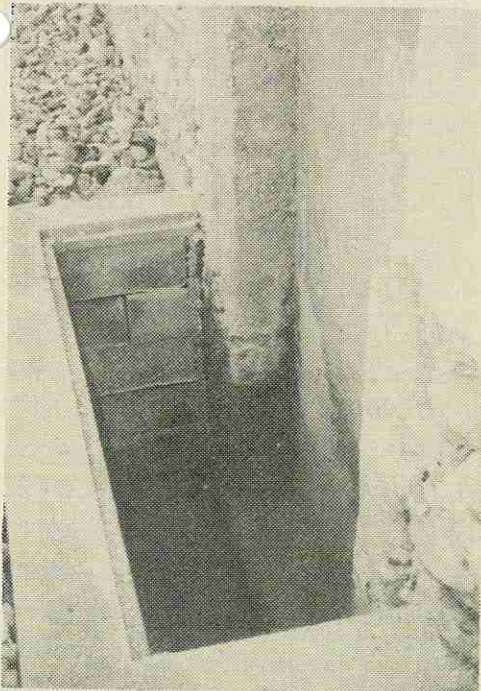
Der alte Eingang liegt 1,50 m unter dem jetzigen Boden.
