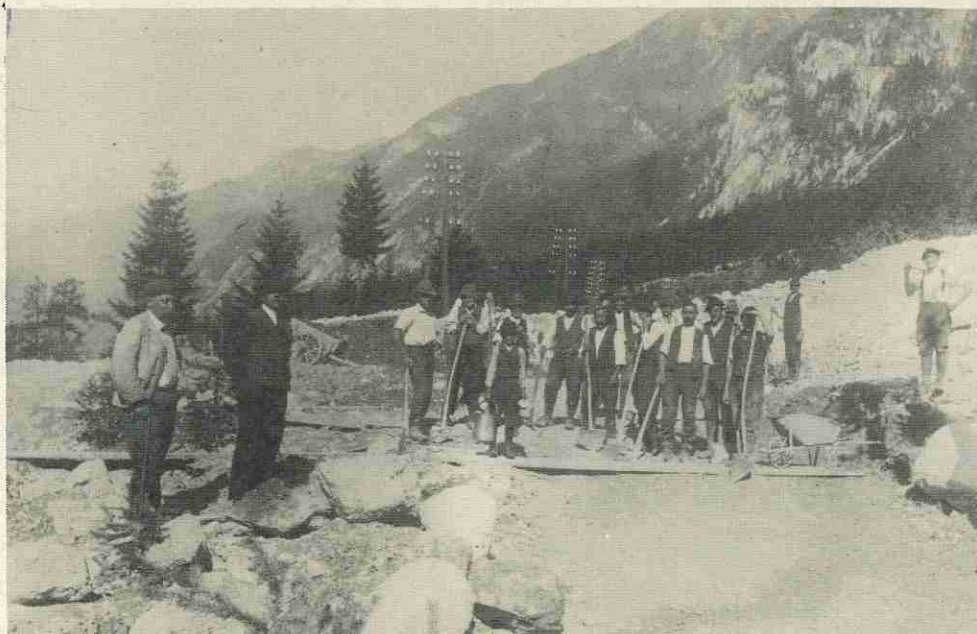
Vermurung der alten Bundesstraße zwischen Flirsch und Schnann in den 20er Jahren; Bilder von Karl Steiner zur Verfügung gestellt.
