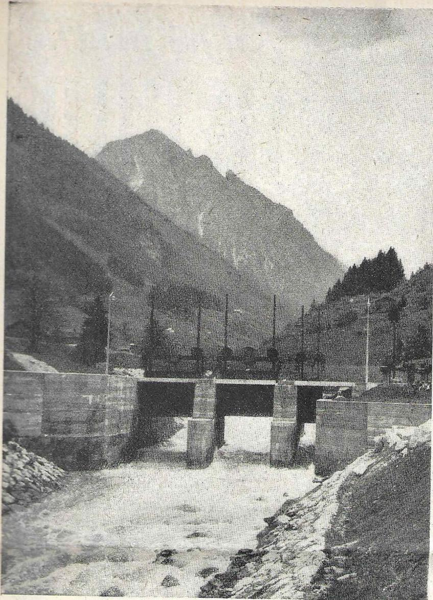
In einem Freispiegelstollen werden die Wasser, die zum Teil aus der Alfenz stammen, zum Teil vom Spullersee-Kraftwerk kommen, einem Wasserschloß zugeleitet. Unser Bild zeigt die geöffneten Sperrschützen der Alfenz, daneben den Einlauf zum Kraftwerk Braz. Diese Anlage ist 8,2 Kilometer vom Kraftwerk entfernt, das die ÖBB mit Strom versorgt.
