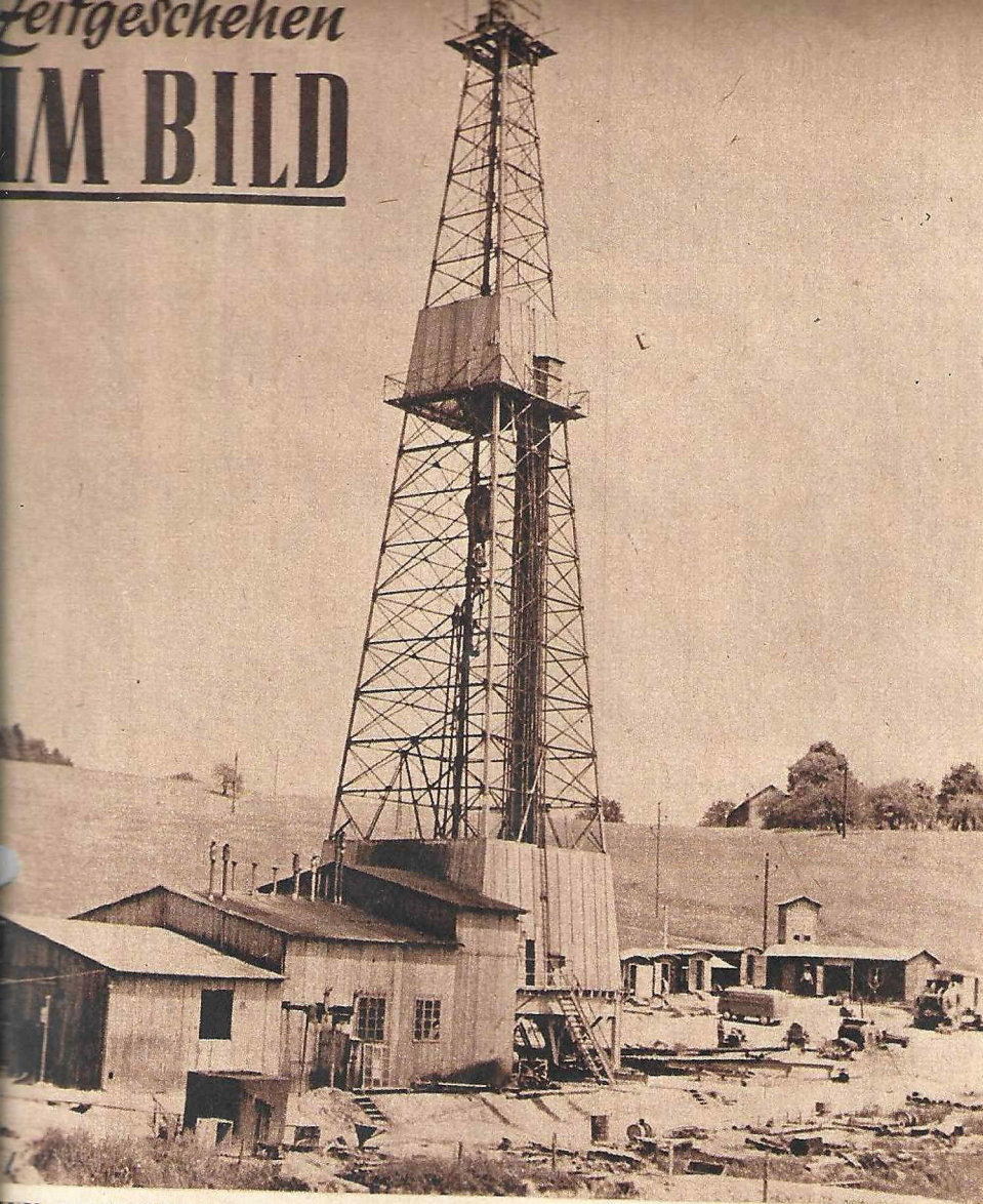
ERSTENMAL seit acht Jahren wurden die Arbeiten der Erdölsucher im Gebiet von Puchkirchen, O.-Ö., von Erfolg gekrönt. Bohrstelle P1 erwies sich als fruchtbar! Seit kurzem liefert das fast 2800 m tiefe Bohrloch täglich 35 Tonnen Öl, das sich als qualitativ besser als das im Gebiet von Matzen geförderte Öl erwies.
