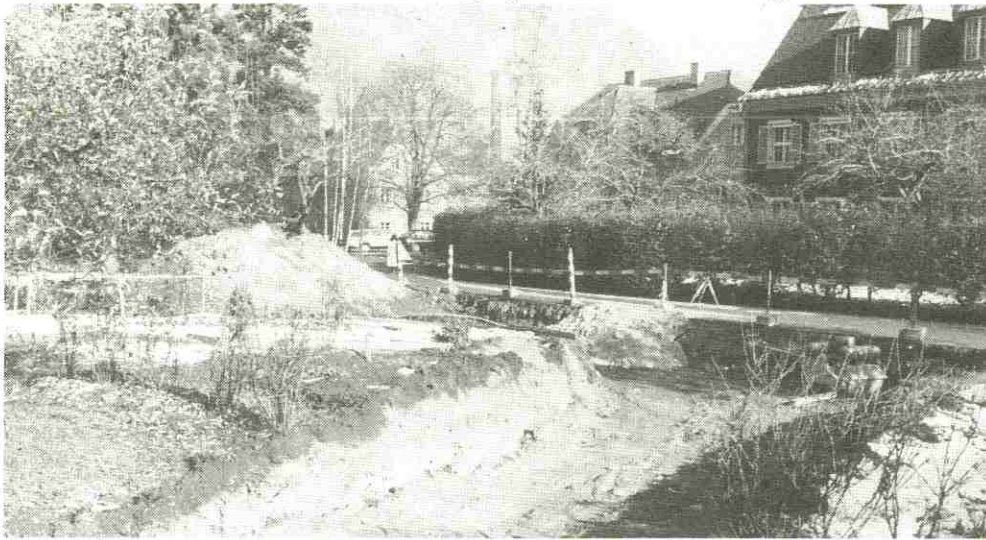
Weg zur Baustelle der Handelskammer
