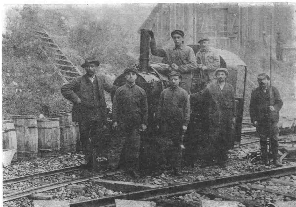
Beim Bau der Reschenbahn, im Jahre 1917, im Bereich des Bahnviaduktes der Arlbergbahn. Das Bild wurde uns von Frau Vorhofer, Landeck, zur Verfügung gestellt.
