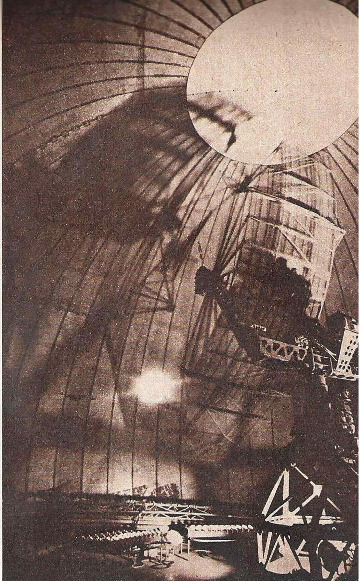
Ständig abgesucht wird der Himmel von einem der riesigen Radargeräte, die sich geschützt innerhalb der aus Plastikgewebe bestehenden Kuppeln befinden. Die vorgeschobene Radarstation leistet so dem US-Luftwarnsystem einen wichtigen Dienst.
