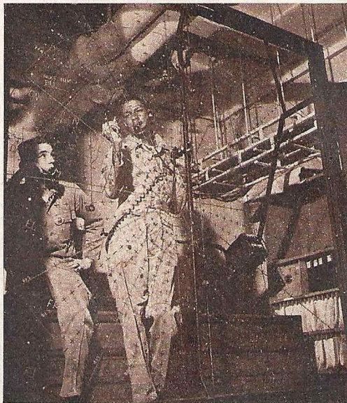
Auf einen Blick kann der Kurs der anfliegenden Maschine von einer durchsichtigen Wand abgelesen werden, auf der der Flugweg laufend eingetragen wird.
